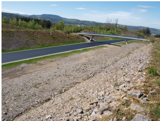
Abbildung 6: Foto Brücke A 98.7
