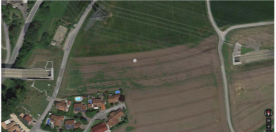
Abbildung 4: Tunnel Groß-Ehrstädt. Bild aus Google Maps
