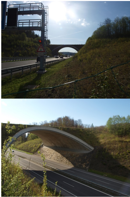
Abbildung 5 Fotos Grünbrücke A 98.4
