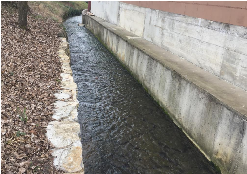
Abbildung 2-3: Dürrenbach in Fließrichtung, geplante Einleitung EL2
