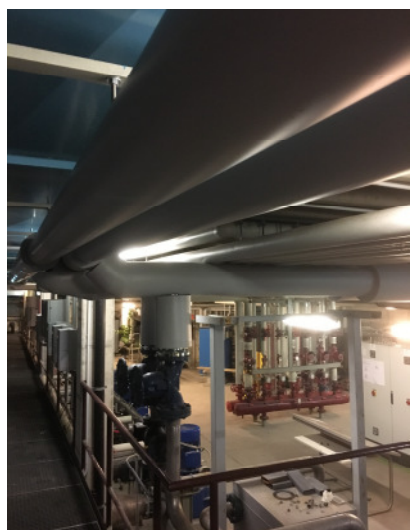
Erneuerte Leitungen der Beckenwassererwärmung
