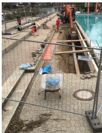
50 m Becken rechte Seite Düsenzuleitung komplett erneuert
