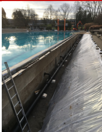
50 m Becken linke Seite Düsenzuleitung komplett erneuert
