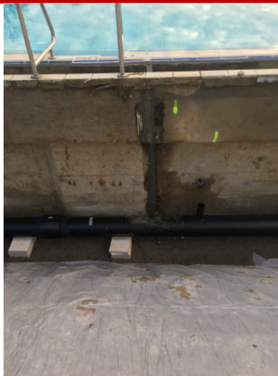
Undichtigkeiten am Becken wurden abgedichtet
