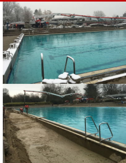
Flüssigboden wurde eingebracht
