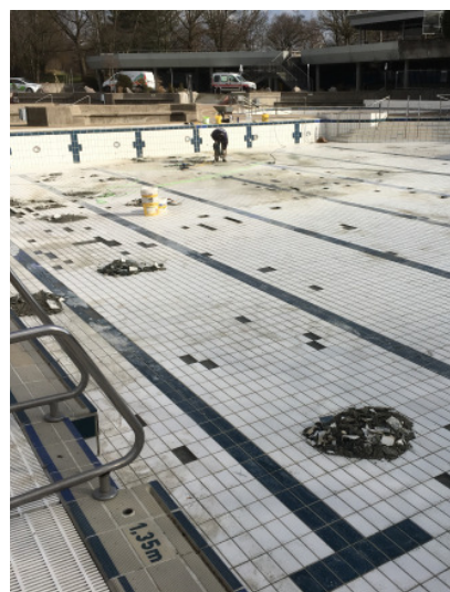
Austausch der defekten Fliesen im Nichtschwimmerbecken
