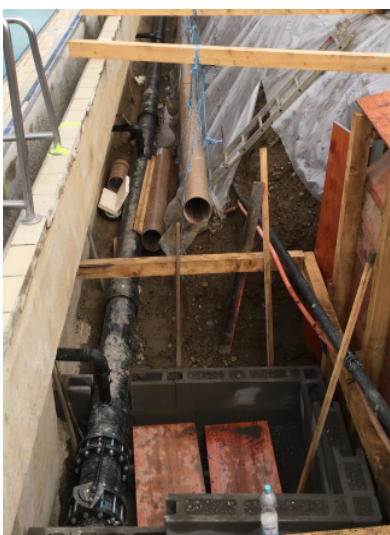
Im vorderen Bereich wurde ein Revisionsschacht angebracht
