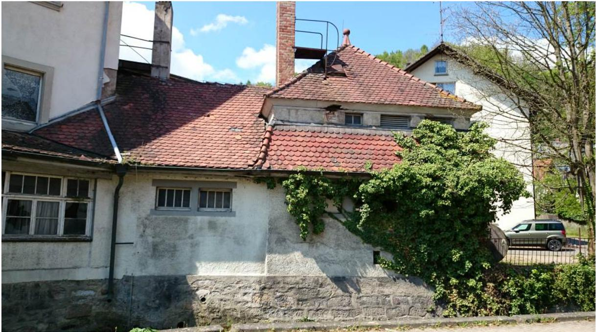
**Abbildung 5** Ehemaliger Gasthof „Sonne“ mit Spalten und Öffnungen im Mauerwerk und am Dach
